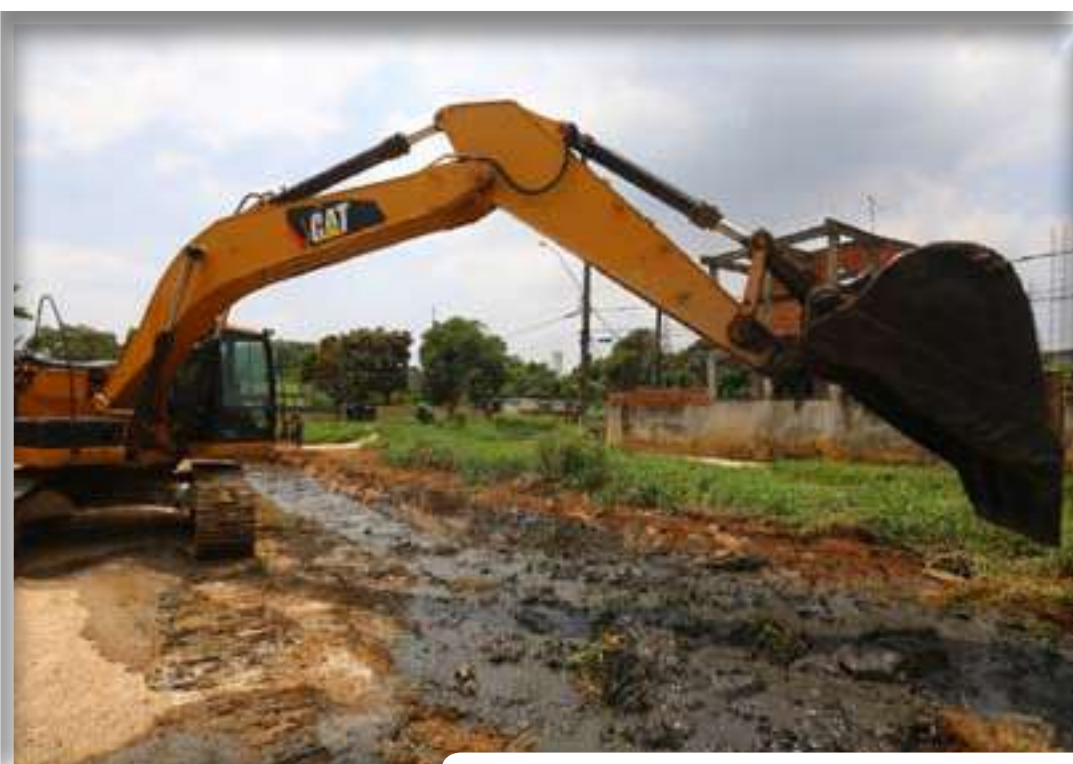
Escavadeira hidráulica trabalha na limpeza e desassoreamento do canal no bairro Roseiral
